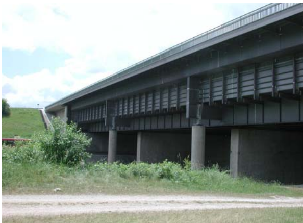
Ansicht der Kanaltrogbrücke Schwarzach
