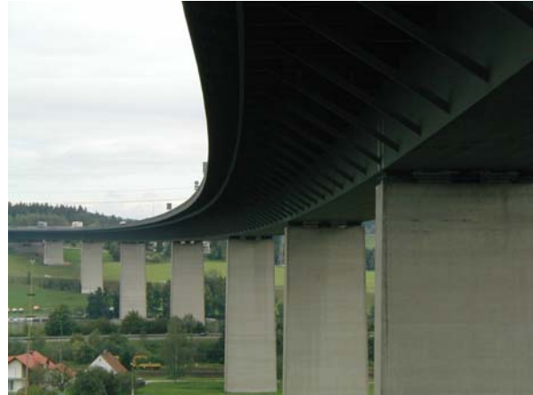
Donaubrücke Schalding (vom Widerlager Passau)
